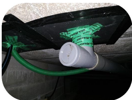
Étanchement de la trappe d'accès au vide sanitaire (joint) au sol du cellier
