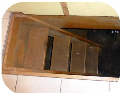
Trappe d'accès au vide sanitaire
