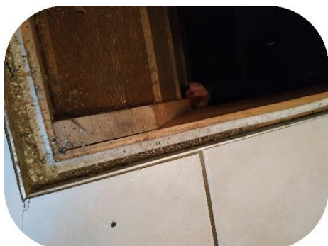
Étanchement de la trappe d'accès au vide sanitaire (joint) au sol du cellier
