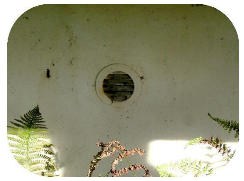
Ventilation du vide sanitaire insuffisante
