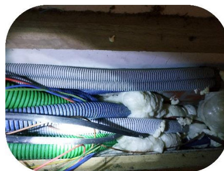
Étanchement passages réseaux au travers de la dalle depuis le cellier (mousse polyuréthane) (3)
