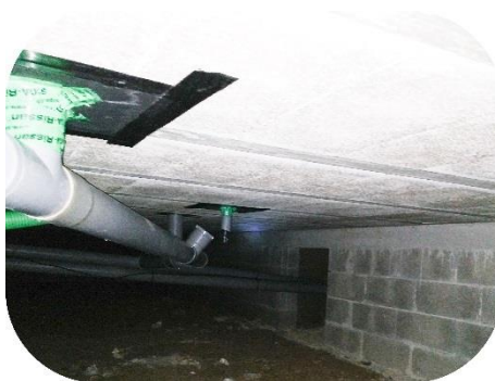
Installation d'une bouche d'extraction VMC en cuisine
