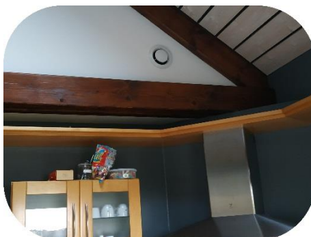
Installation d'une bouche d'extraction VMC en cuisine
